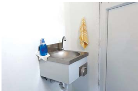
Slika 11.14: Umivalnik za roke z mehanizmom za odpiranje s kolenom (vir: V. Magdić)
